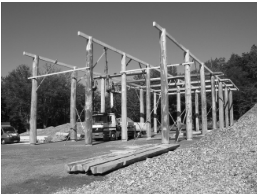
Im Bau: Das neue Holzschnitzellager in Haina.
